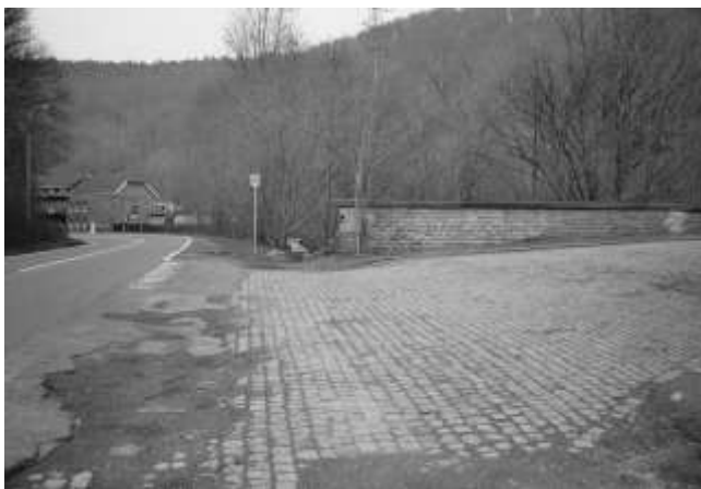
Theux – La Chaussée de Spa (N 62) entre Spa et Spixhe (vers l'avant), à hauteur du pont sur la rivière Wayai (à droite) menant au site de l'ancienne gare de La Reid – 31 mars 2007
