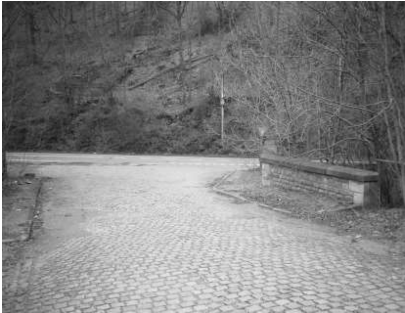
Theux – La Chaussée de Spa (N 62) entre Spa (vers la gauche) et Spixhe (vers la droite), vue de l'accès à l'ancienne gare de La Reid – 31 mars 2007
