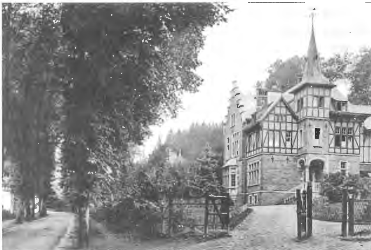
12. La villa « Red Castle », avenue de Barisart à Spa, où Georges Neyt avait élu domicile pendant la construction du manoir de Lébioles.
