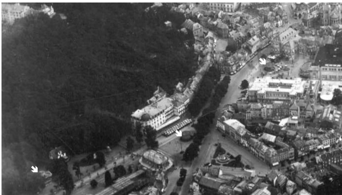
Les trois kiosques sur une même vue (Coll. Privée)
