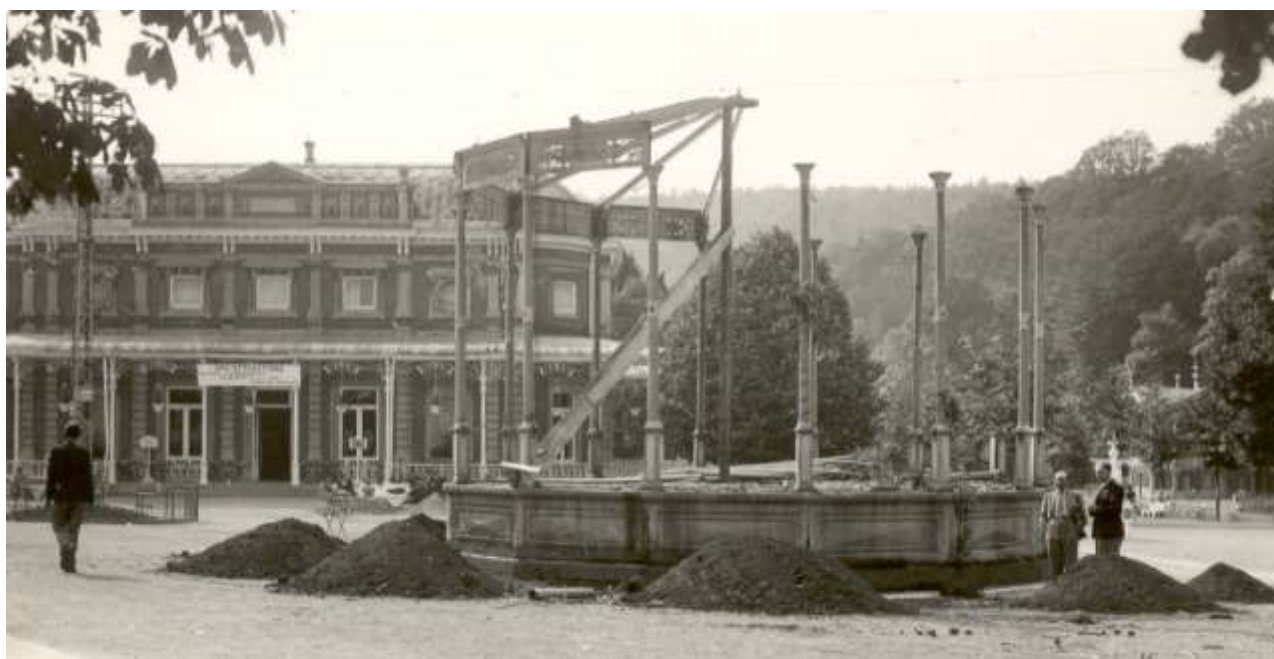
Le kiosque de la place Royale en démolition ; à droite G.E. Jacob et G. Spailier 23 ,
