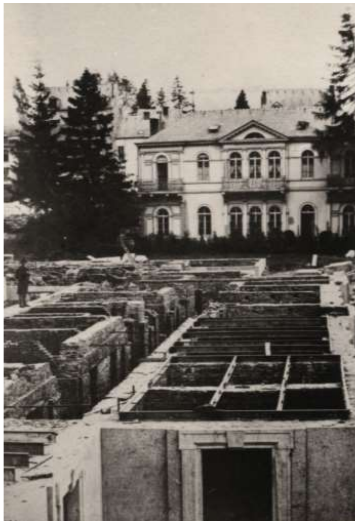
Le nouvel établissement de bains sort de terre (Coll. Musée de la Ville d'eaux)
