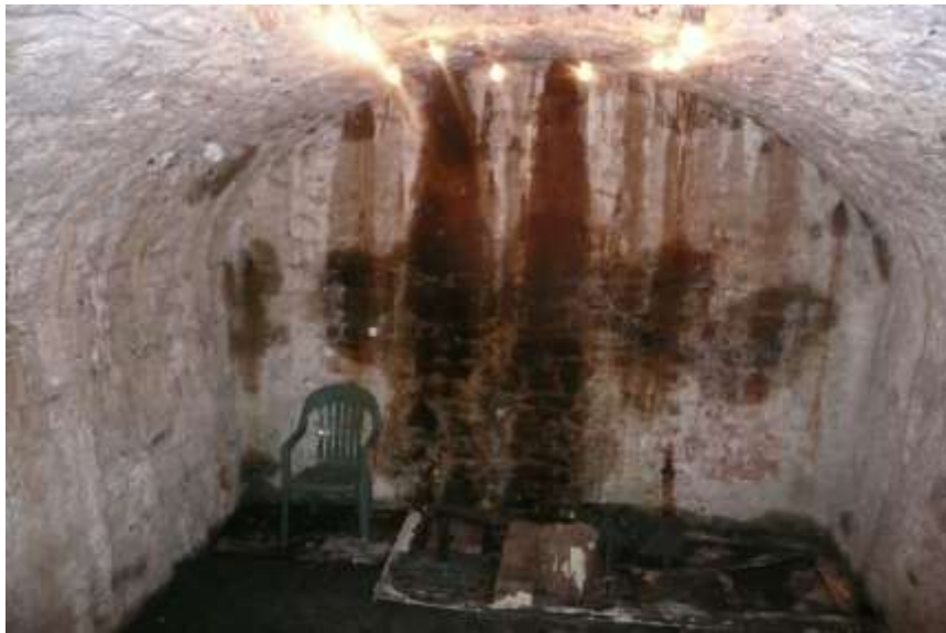
Entrée, couloir 1 et 2, puis la glacière - Photographies J. Toussaint
