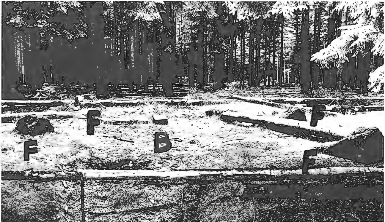
Vestiges du signal géodésique. B = borne - F = fondation. Cliché de l'auteur.
