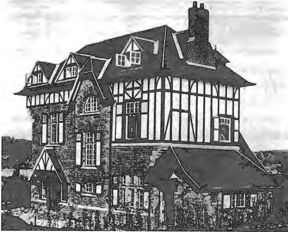
Fig. 5 – G. Hobé, façade postérieure d'origine de la villa Little Lodge à Spa. [Bénédite (1901)].
