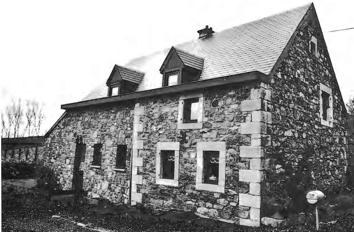
1. Ancienne laiterie de la ferme actuellement dite «du comptoir» doublée de volume par la famille Léonard à usage d'habitation (photo de l'auteur)
