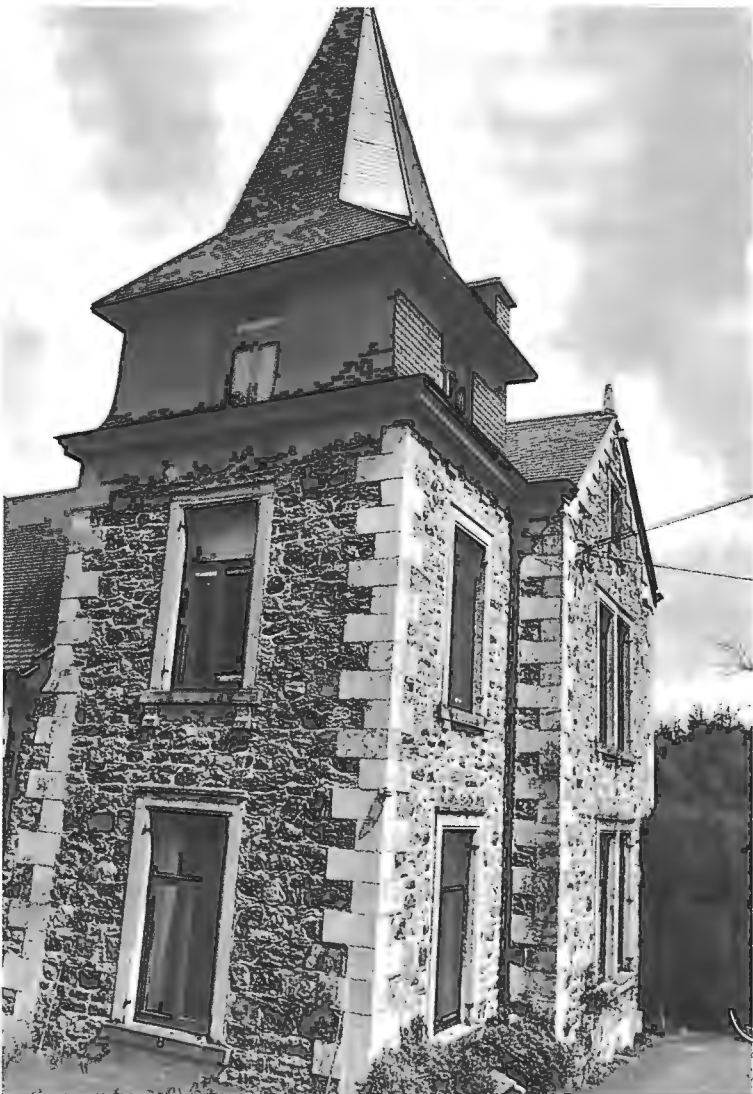
9. La tour d'El Fagne après réfection de la toiture et des châssis (photo de l'auteur)
