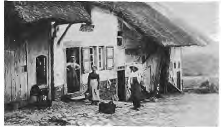
La ferme Jamar (démolie) à Frainfaz - date : 10 août 1904.
