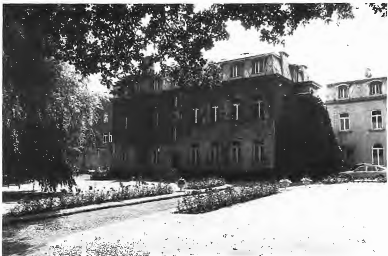
Façade arrière, vue du parc royal
