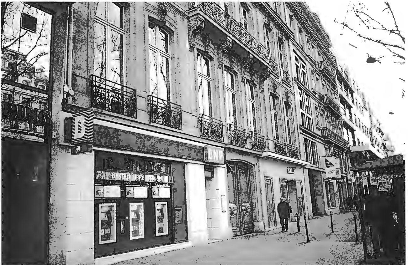
L'entresol aux sept fenêtres du 11 boulevard de la Madeleine : Marie Duplessis y vécut de 1844 à sa mort, le 3 février 1847.
